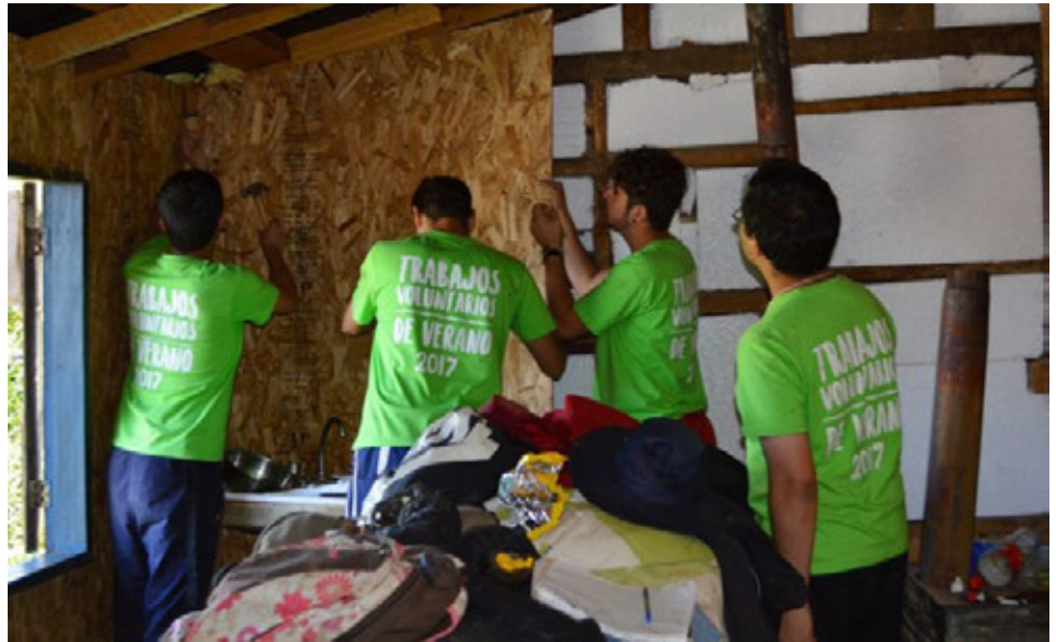
Se trató de una importante experiencia para todos los voluntarios que formaron parte de estos trabajos, provenientes de todas las sedes de la zona centro sur, desde Rancagua a Punta Arenas.
